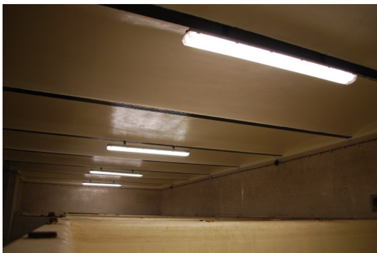
Opravené stropy a osvětlení na velké spilce
