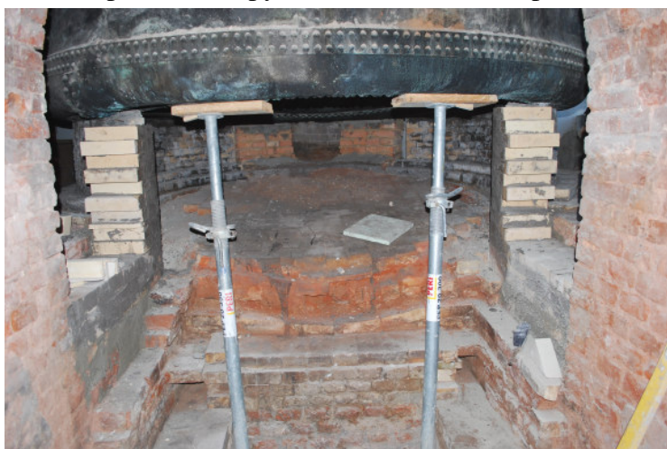
Složitá oprava topeniště pod varním kotlem
